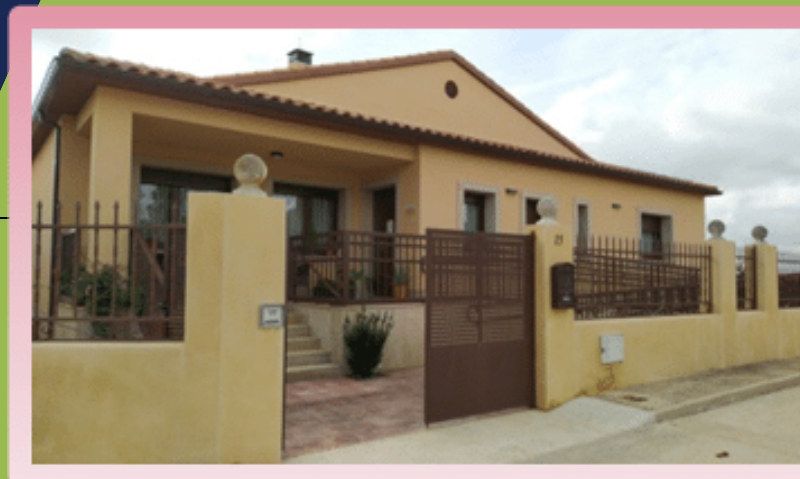
Vivienda Tutelada “Teso de la Vega”. C/Velasco, 15 (Gomecello)
